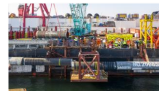
最終鋼管敷設完了 (2021年9月10日)
